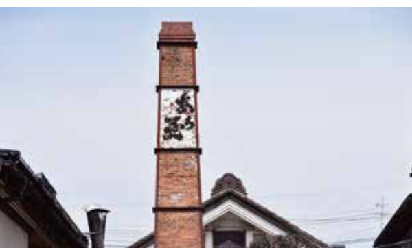
創業当時からそびえ立つレンガ造りの煙突は、町のシンボルにもなっている
